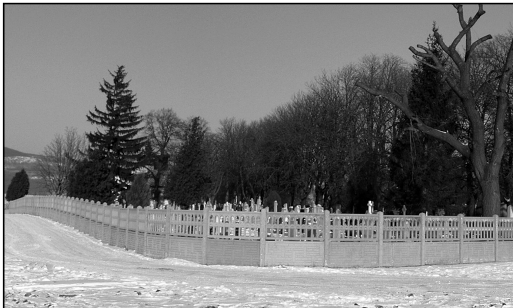
A temető elkészült új kerítése
